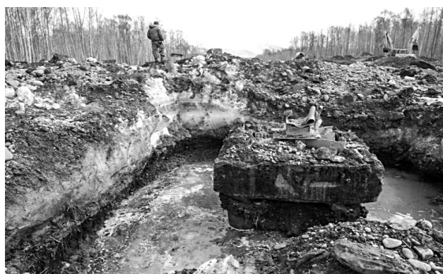
Рис. 13. Котлован вокруг эстакадной опоры ВПМГ на свайном фундаменте перед её демонтажом (западная часть долины р. Авачи). По периметру котлована – наледь высотой 2 м, в которую к концу зимы вмёрз трубопровод ВПМГ (фото 27.04.2012 г.)
