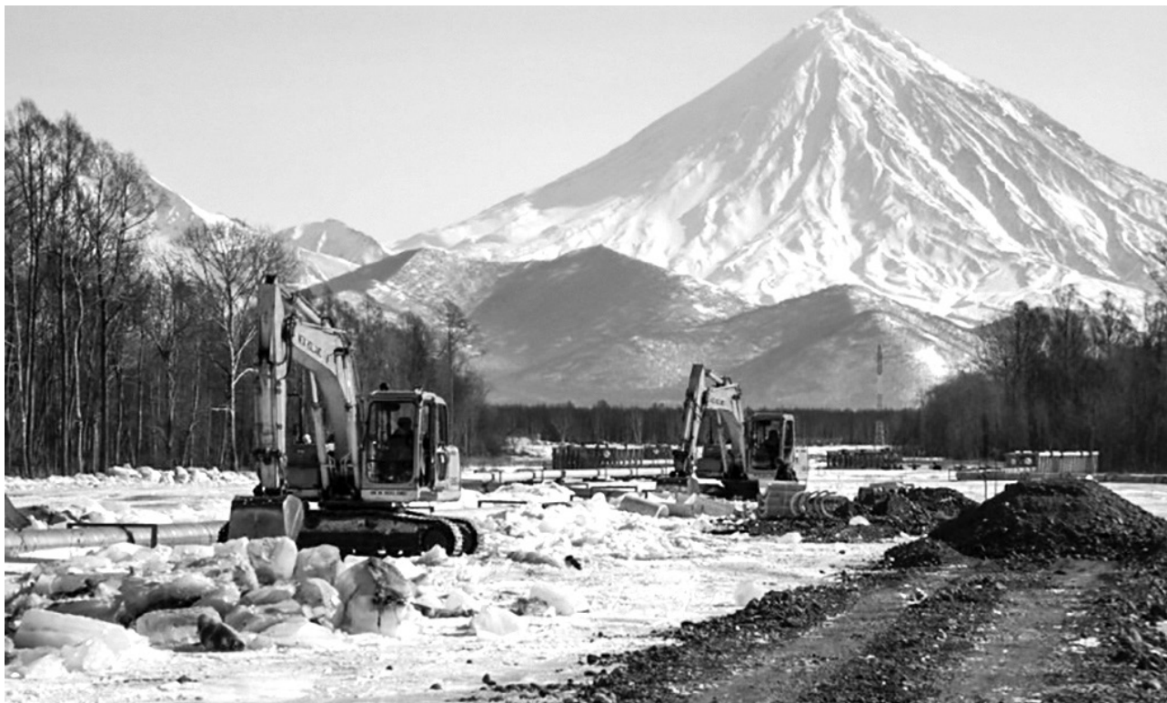
Рис. 2. Начало реконструкции воздушного (балочного) перехода МГ через р. Авачу по состоянию на 11.03.2012 г. В западной части долины с декабря 2011 по март 2012 г. шёл процесс интенсивного образования наледей, сопровождавшийся вмерзанием в лёд трубопровода
