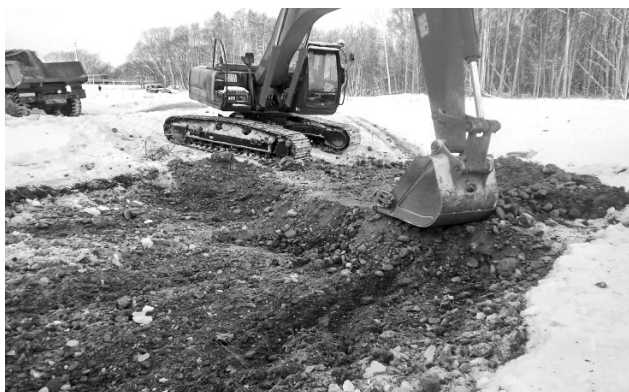
Рис. 21. Демонтаж ранее уложенных габрионов в руслах второстепенных пойменных проток р. Авачи по иску природоохранного прокурора (фото декабрь 2012 г.). Экскаватор разравнивает грунт валика обратной засыпки для последующей вторичной укладки габрионов над ним
