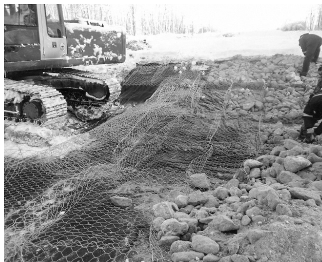
Рис. 22. Повторная укладка габрионов, декабрь 2012 г.
