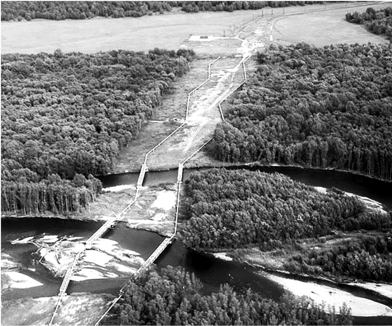
Рис. 1. ВПМГ через долину р. Авачи. На переднем плане – центральные протоки с балочными переходами ВПМГ (фото О. А. Черныгиной, июль 2010 г.)
