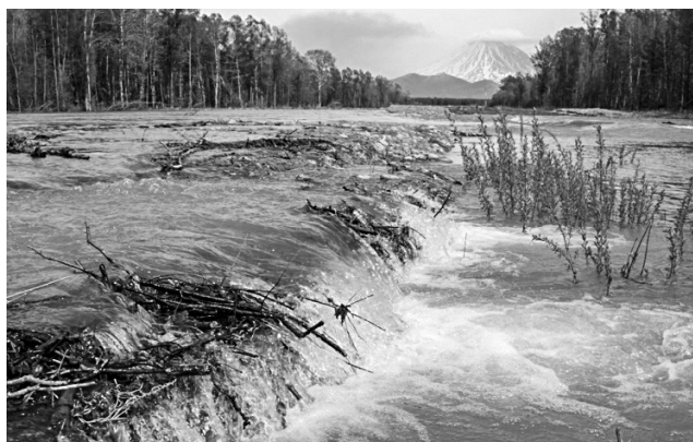
Рис. 23. Через год после реконструкции (фото 06.06.2013 г.). Даже после зимнего (декабрь 2012 г.) удаления части грунта из валиков обратной засыпки и углубления габионов в руслах ГТС в половодье продолжает функционировать как переливная дамба-перекат
