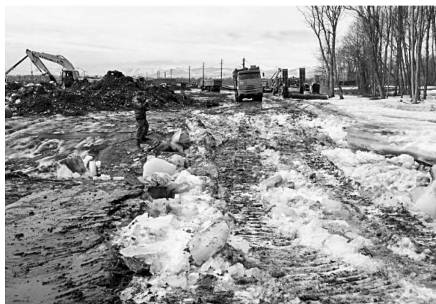
Рис. 16. Принудительно разрушенная экскаватором ледовая переправа через русло второстепенной пойменной протоки в западной части долины р. Авачи. Дальнейшие переезды техники через протоку осуществлялись вброд (фото 27.04.2012 г.)
