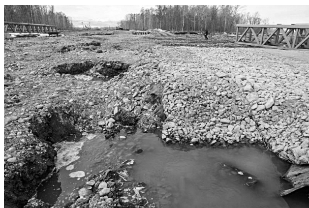
Рис. 12. Габионы, размещённые на льду протоки р. Авачи в центральной части долины (с частичным провалом в русло после распада льда) в створе ППМГ. На заднем плане – демонтированные конструкции ВПМГ (фото 27.04.2012 г.)
