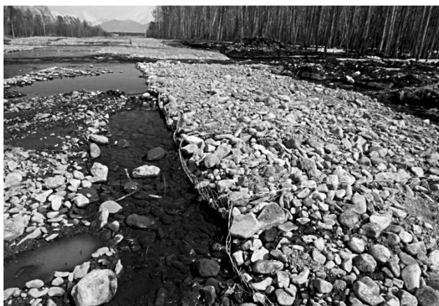
Рис. 19. Габрионы в створе основной нитки. В результате нарушения естественного продольного профиля двух правобережных второстепенных проток и планово-высотных отметок прилегающих участков поймы после реконструкции перехода МГ образовались искусственные гидрологические ловушки для молоди лососей, в которых после снижения уровня воды в реке происходила их гибель (фото 16.05.2012 г., начало весенне-летнего половодья)
