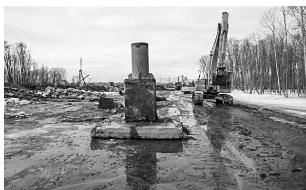
Рис. 14. Демонтированная эстакадная опора ВПМГ на столбчатом фундаменте, извлечённая из-под льда (наледи) в западной части долины р. Авачи (фото 27.04.2012 г.)
